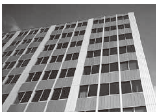
東京大林組ビル ②
