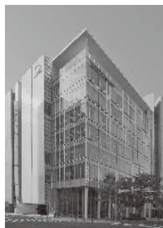
第一三共(株)札幌支店ビル ①
