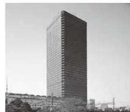
世界貿易センタービル ②
