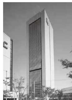
ワールド新本社ビル ⑳
