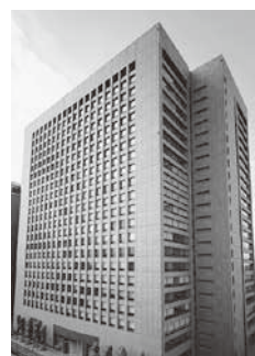
伊藤忠商事東京本社ビル ⑨
