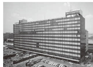
改装 東京駅八重洲口本館 ①
